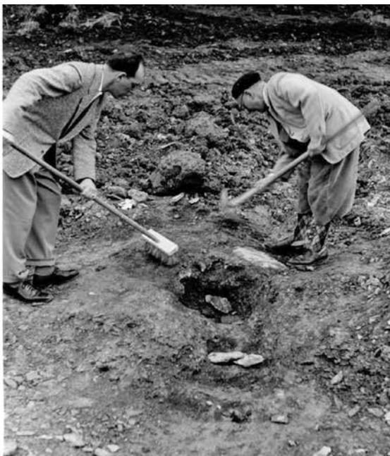
Abb. 92: Freilegung eines als Schmiedesse umfunktionierten Verhüttungsofens an der Minnebach-Reithalle 1956 (Siegen-Winchenbach).
