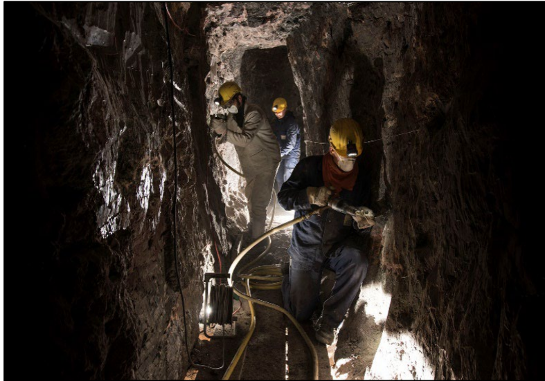
Arbeit untertage: Putzen der Profile mit dem Schrämmhammer.
